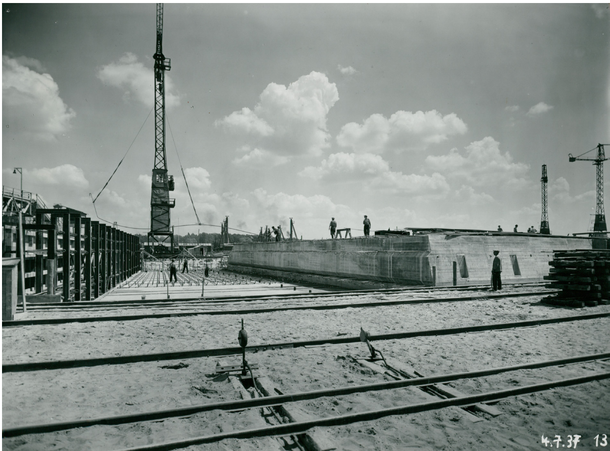
Abbildung 35: Baustellenfoto der Fundamente der Kongresshalle, 1937, © Berlin-Brandenburgisches Wirtschaftsarchiv e.V.
