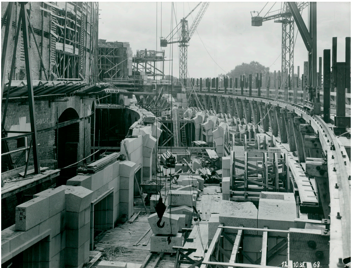
Abbildung 20: Baustelle der Kongresshalle, 1938, © Berlin-Brandenburgisches Wirtschaftsarchiv e.V
