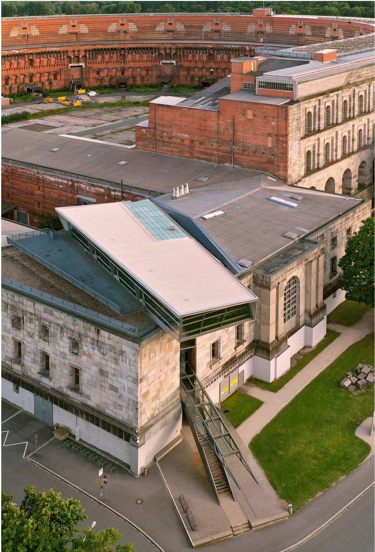
Abbildung 24: Luftbild Eingang des Dokumentationszentrums im nördlichen Kopfbau, 2017, © Hajo Dietz
